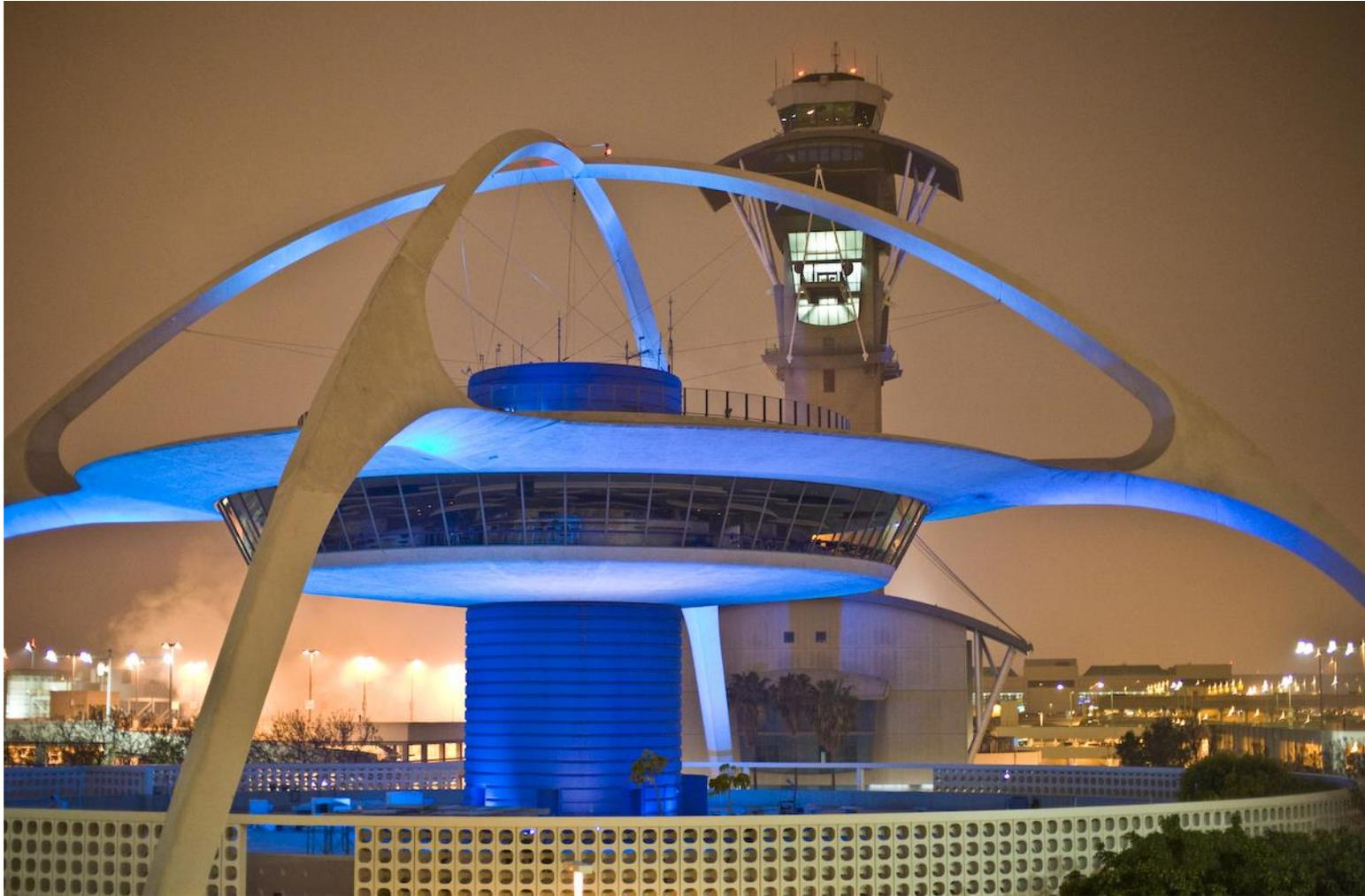
Le « Thème Building » à l'Aéroport International de Los Angeles, construit en 1961 a la forme d'un disque volant posé sur 4 jambes formés par des arcs de 40 m. de hauteur
